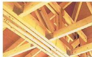
各種の補強金物が効果的に使用される小屋組み
